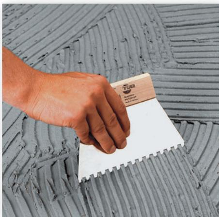
Beim Verwenden der Klebspachtel oder der gezahnten Glättkelle wird der Fliesenkleber gleichmäßig auf dem Untergrund verteilt.
