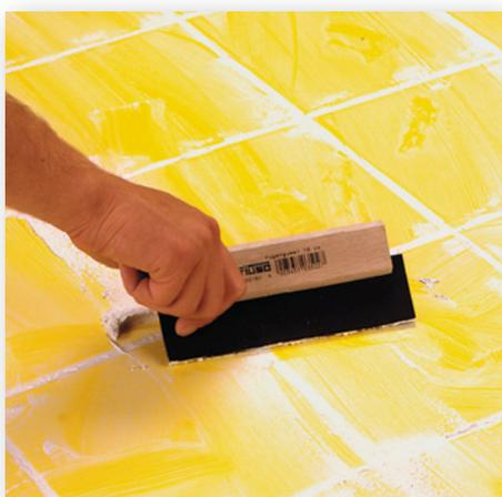
Zum Verteilen und kraftvollen, homogenen Einschlänmen der Fugenmasse ist der Fugengummi oder das Fugbrett das richtige Werkzeug.
