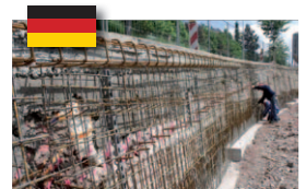
Sanierung Stützwand, Altensteig, Deutschland
